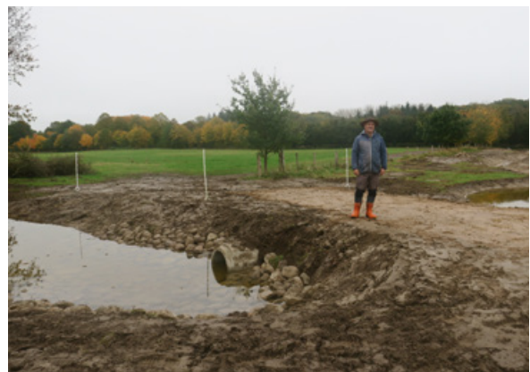
Der Bereich der Verrohrung nach der Maßnahme Herr Albrecht auf dem neu geschaffenen Bachdurchlass vor dem Übergang zum bestehenden natürlichen Fließgewässer. Foto: C. Gasse
